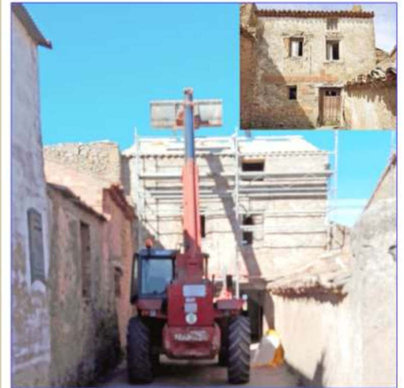
Casa en la que vivió Bécquer, actualmente en rehabilitación
